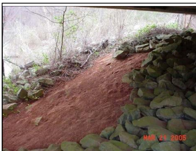
Fig. 3.1 – Enrocamento removido (GDOT, 2012) Fig. 3.2 - Escorregamento de solo e pedras
