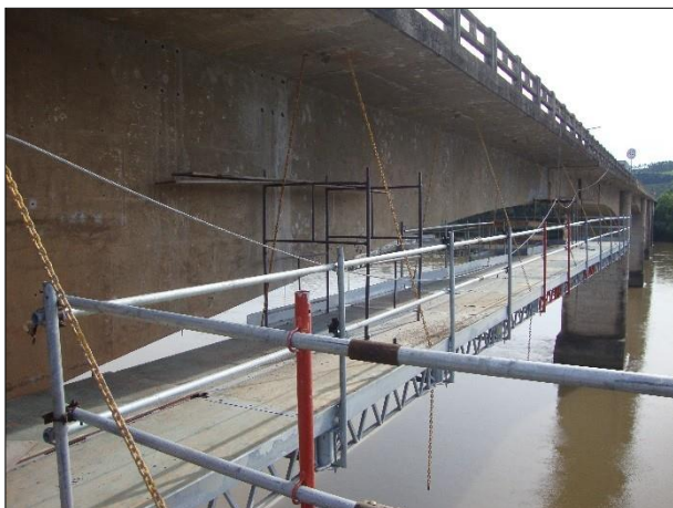
Fig. 5.2 - Plataformas suspensas
