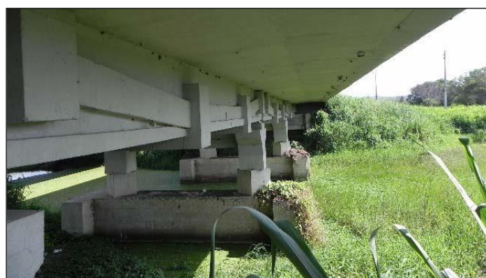
Fig. 3.3 – Vegetação sobre os blocos de fundação
