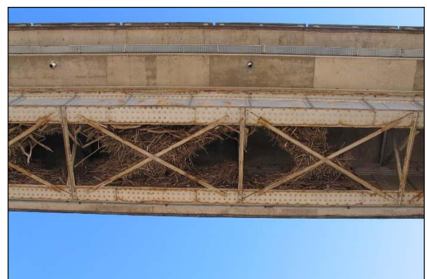
Figura 3.4 – Material retido na estrutura
