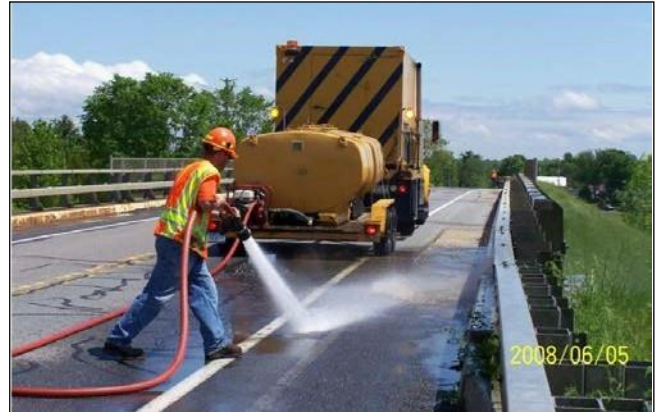
Fig. 5.2 – Jateamento d'água sob pressão*
