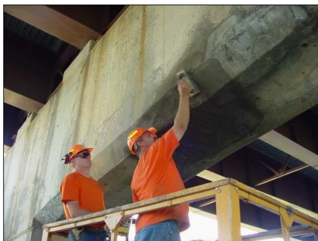
Fig. 3.2 – Regularização do material projetado*
