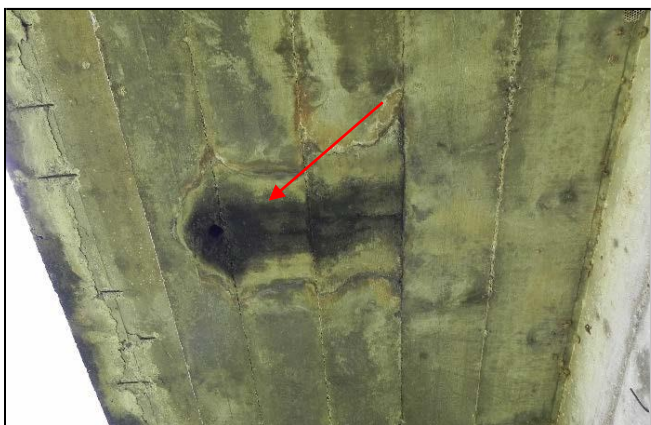
Fig. 3.1 – Dreno obstruído
