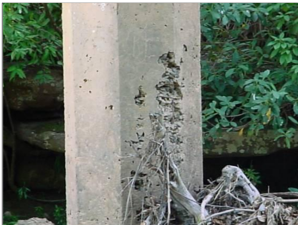
Figura 3.3 – Falhas de concretagem
