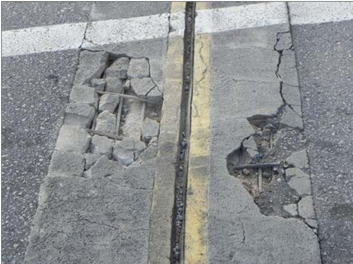
Fig. 3.3 – Berços e lábios poliméricos danificados
