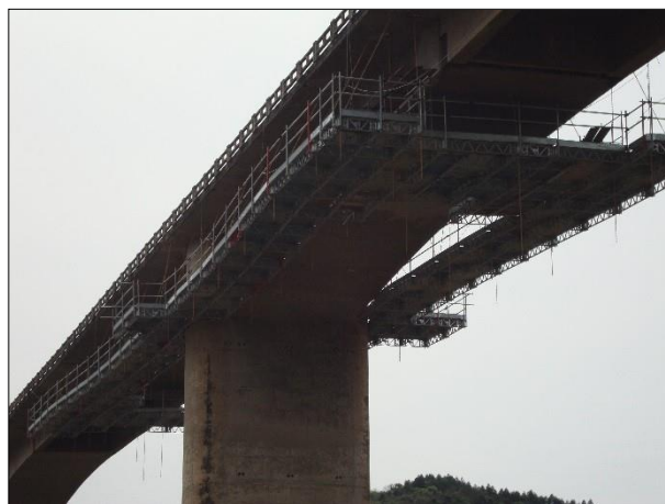
Fig. 5.3 - Plataformas suspensas
