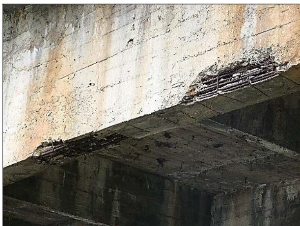
Figura 3.5 – Falhas de concretagem
