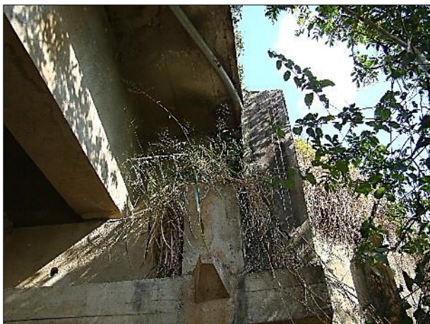
Fig. 3.3 – Vegetação na junta do encontro
