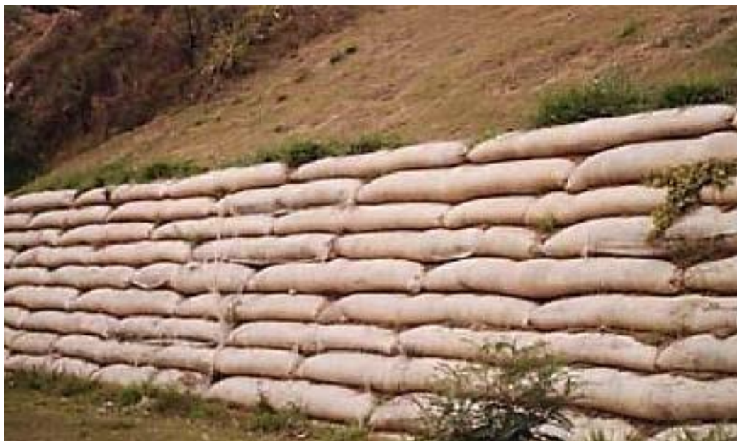
Fig. 4.1 – Contenção com solo-cimento ensacado (SICRO, 2017).
