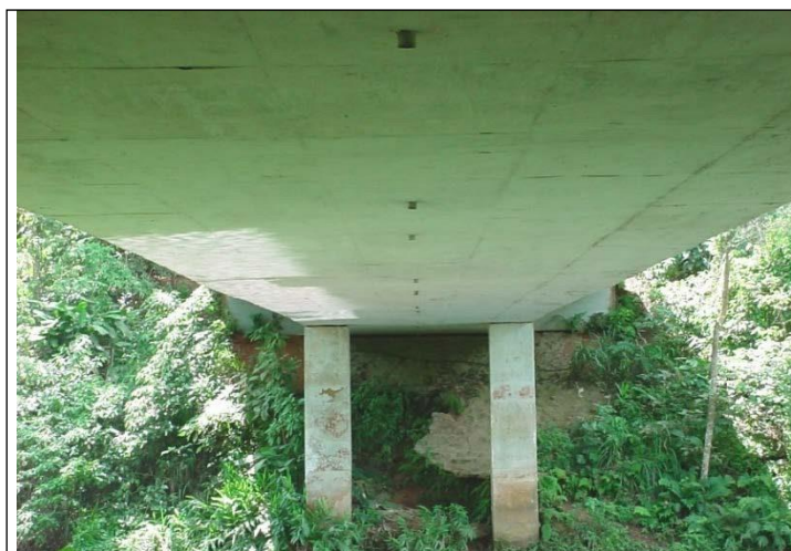
Fig. 3.3 – Drenos na estrutura em caixão
