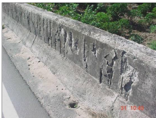
Fig. 3.2 – Deslocamento na barreira rígida
