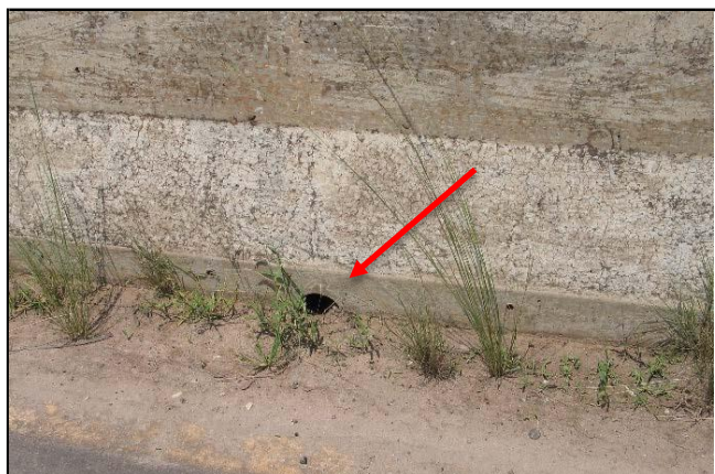
Fig. 3.2 – Dreno obstruído
