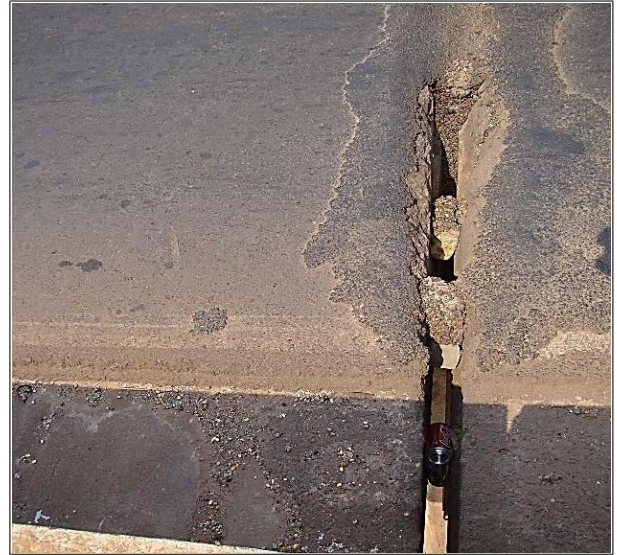
Fig. 3.2 – Junta obstruída
