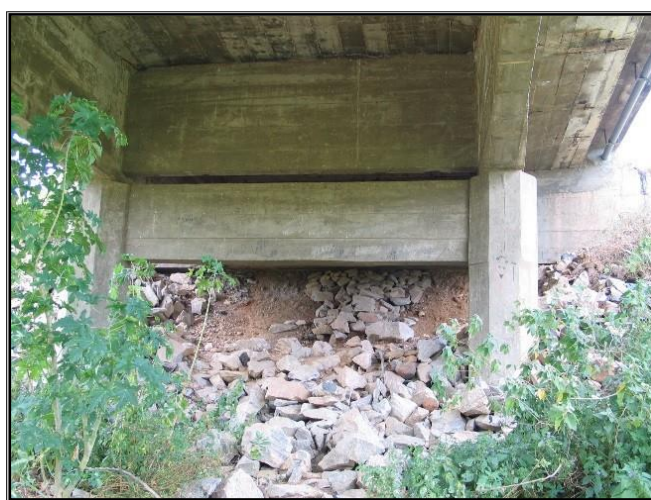
Fig. 3.1 – Enrocamento removido (GDOT, 2012) Fig. 3.2 - Escorregamento de solo e pedras
