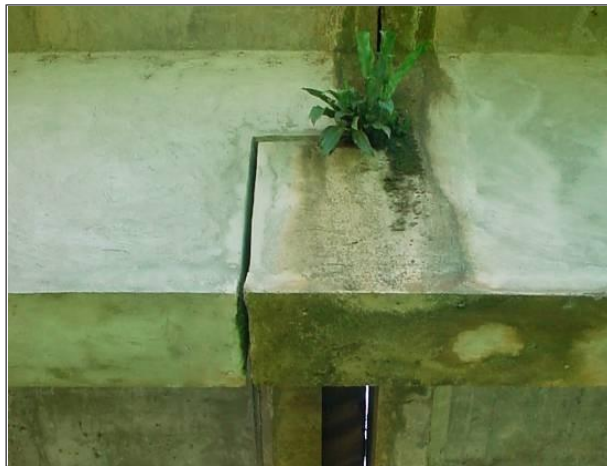
Fig. 3.2 – Crescimento de vegetação na junta
