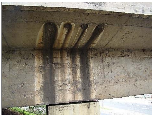
Fig. 3.1 – Drenos inadequados
