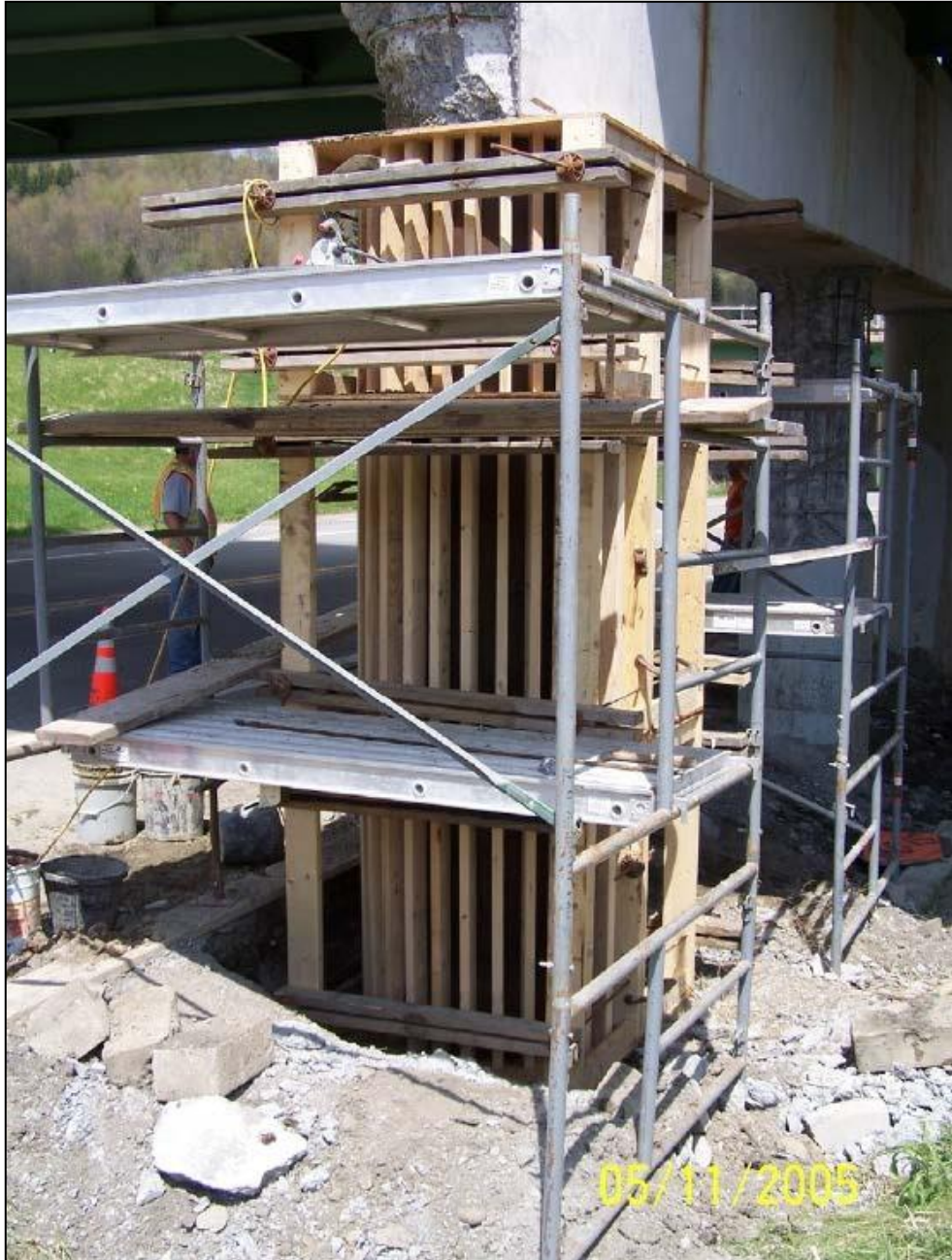
Fig. 5.1 – Plataformas apoiadas no solo (NYSDOT, 2008)
