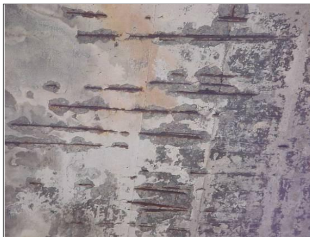
Figura 3.6 – Cobrimento deficiente
