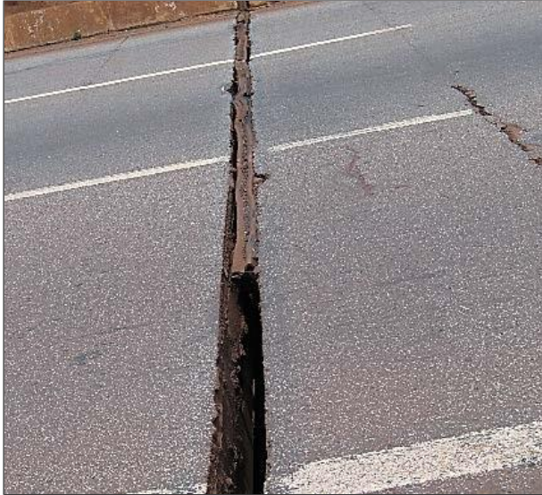
Fig. 3.1 – Elastômero danificado
