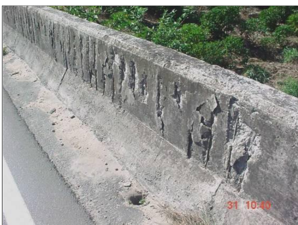
Figura 3.5 – Falhas de concretagem
