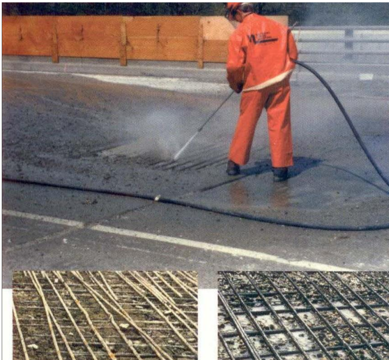
Fig. 5.1 – Hidrodemolição com equipamento manual – na parte inferior da figura, à esquerda amostra de corte do concreto com rompedores pneumáticos; à direita com hidrodemolição (Revista RECUPERAR – Set/Out 94)
